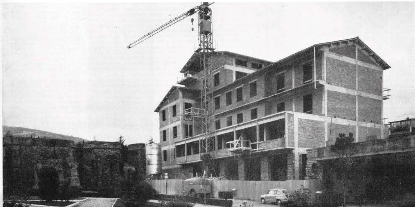
Borgosansepolero - Le cannoniere del Buontalenti, il monumento di Mazzacurati; e «l'Albergo» dell'architetto Giuseppe Margaritelli.
